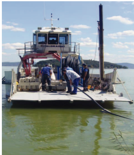
Posa in opera condotta
