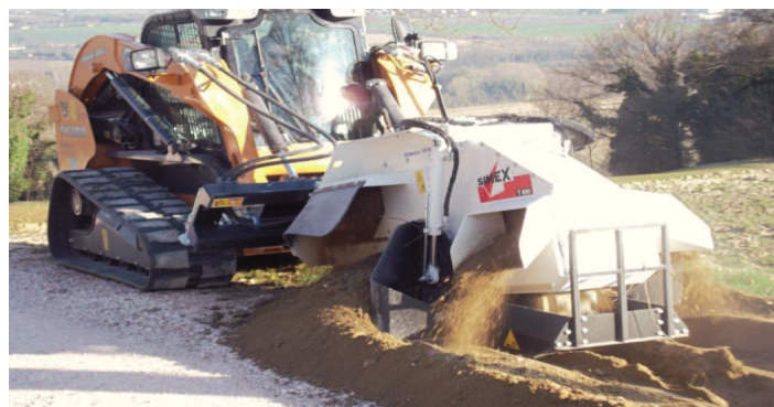
Macchina operatrice al lavoro
