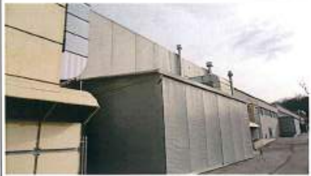
Impianti aspirazione capannone esistente
